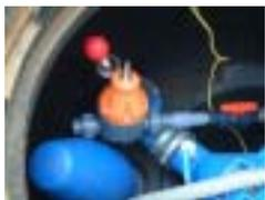
自動吸気装置を設置した75mm真空弁ユニット
