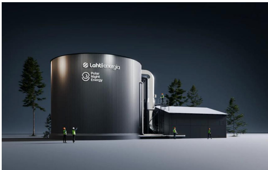
図2. Lahti Energia 社向け熱エネルギー貯蔵システム
