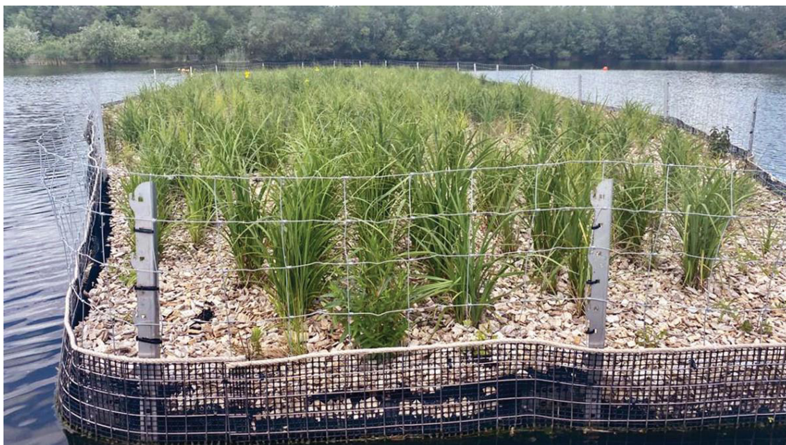
図3 貯水池で設置が進む浮き型葦床
