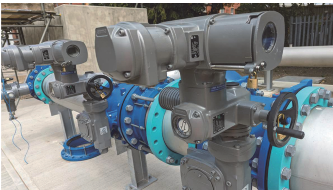
図2 Aumaアクチュエータとギアボックスが付いたDN450バルブ
