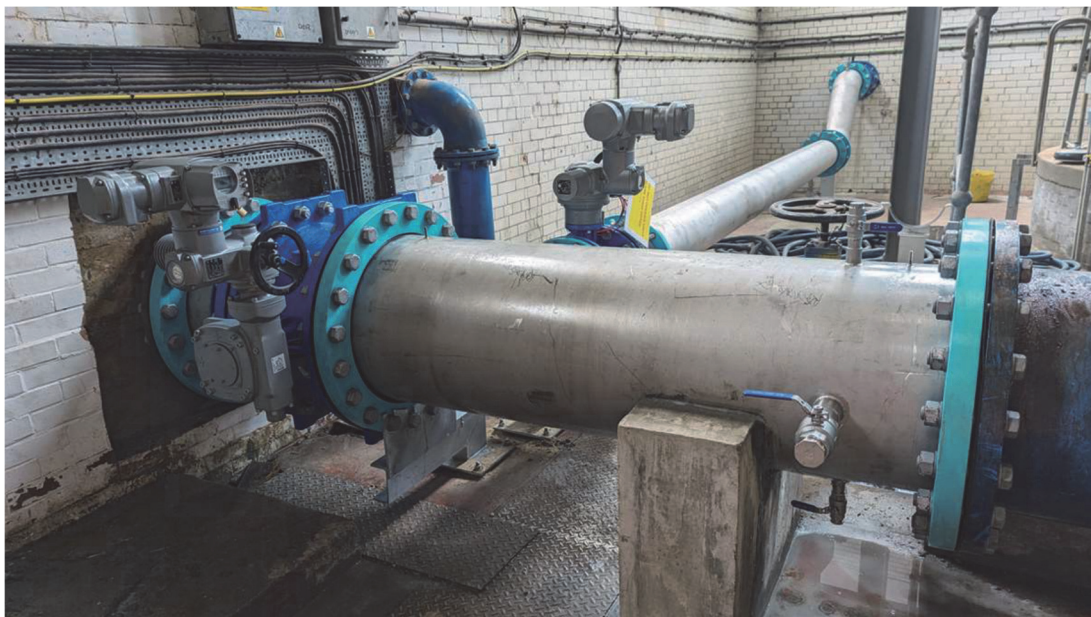
図1 James エンジン室内のDN600/DN300管
