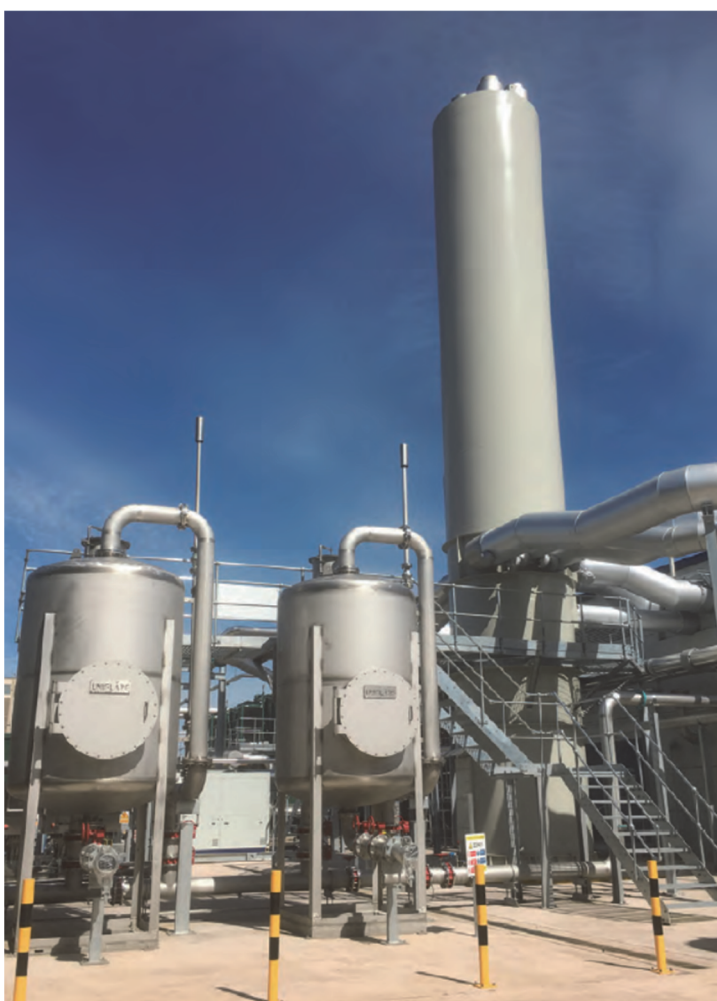
図3 Minworth THP シロキサンプラント カーボンフィルタ設備
