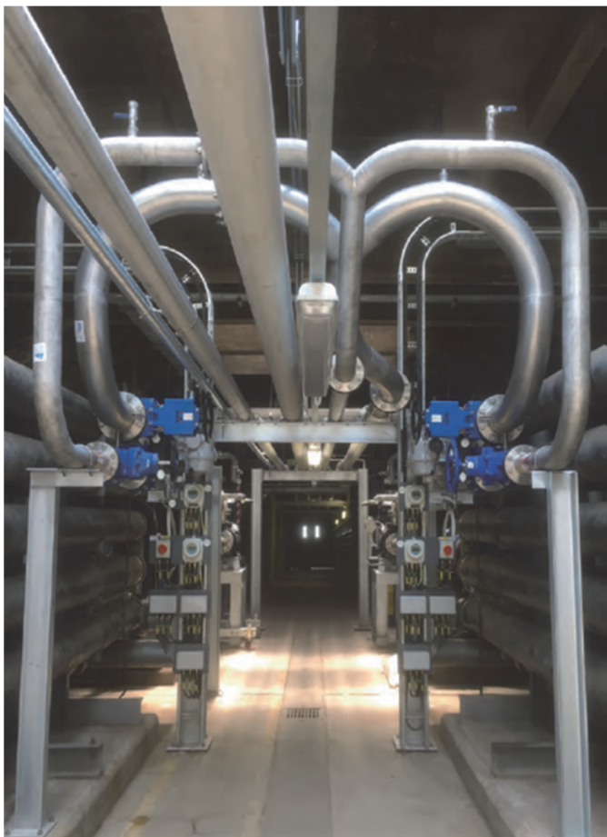
図2 Minworth THP ダイジェスター再循環パイプ廻り
