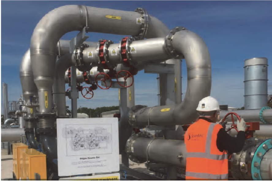
図4 Minworth THP バイオガスブースター
