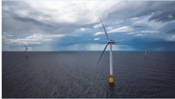
図4 スパー式の例（Hywind、Equinor 社）
