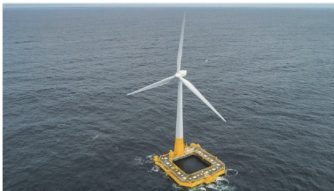
図2 バージ式の例 (Dampingpool、IDEOL 社)
