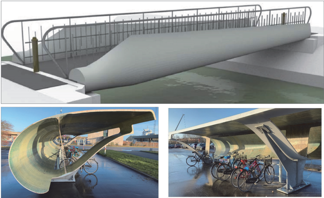
図6 ブレードの別用途利用例（上：橋、下：自転車シェルター）
