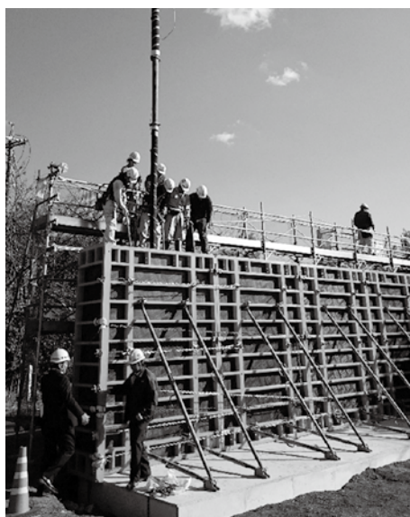
写真1 生コンクリートの施工状況
