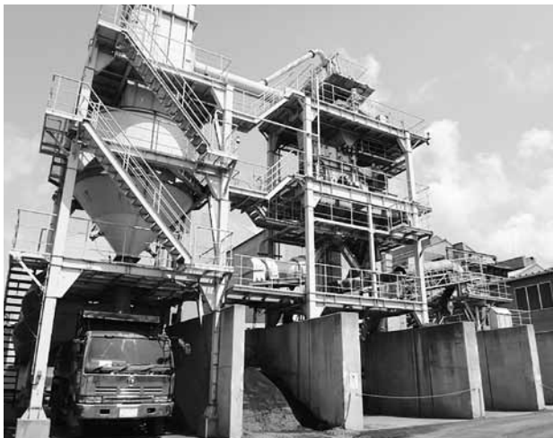
写真3 溶融スラグ製砂設備外観
