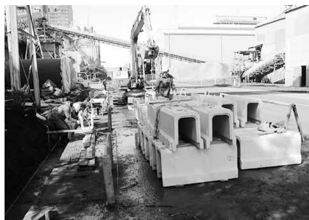
写真6 U字側溝埋設工事状況
