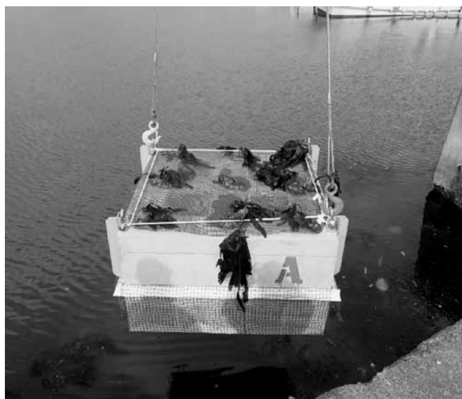
写真2 漁礁ブロックの設置状況
