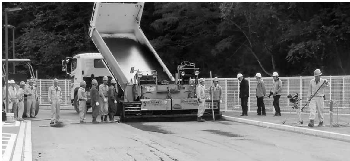
写真3 溶融スラグ入り製品（アスファルト及び境界ブロック）試験施工時現地説明会の様子
