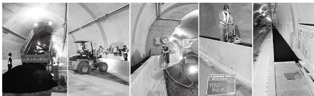
写真1 監視員通路工の中詰土用エコスラグの施工状況 (監査廊側)
