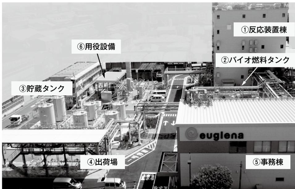
① 反応装置棟：原料(ミドリムシ油脂や廃食油)からバイオジェット燃料とバイオディーゼル燃料を製造する設備
