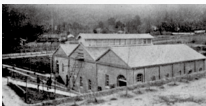
日本初の事業用水力発電所(蹴上発電所)
