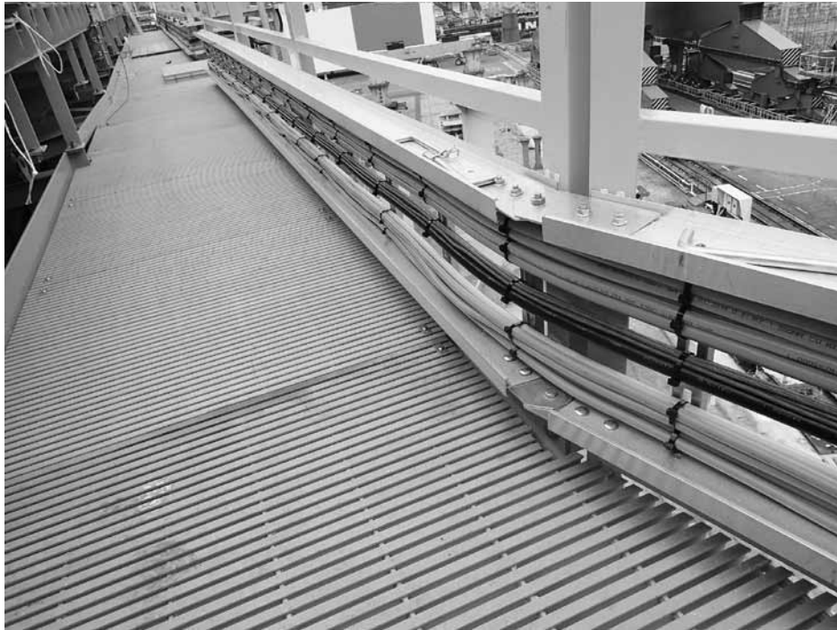
写真2 FRP製グレーチング
