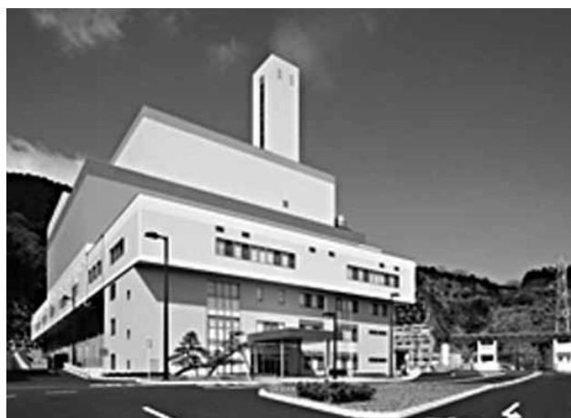
写真1 静岡市西ヶ谷清掃工場
