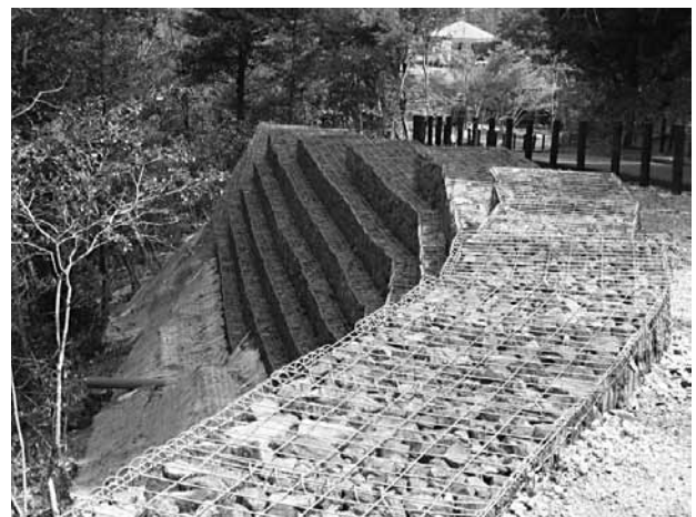
写真2 金網かご擁壁の外観
