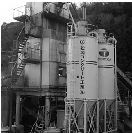
写真5 愛知工場・プラント
