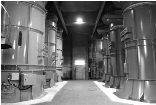
写真1 送・排風機(更新後)古城立坑
