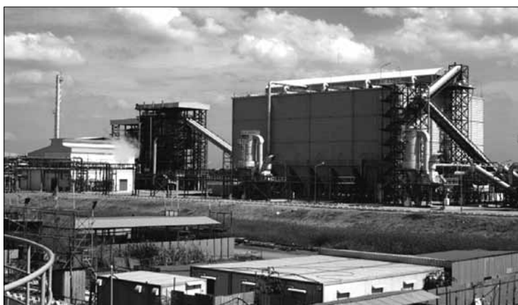
写真4 タイ味の素 アユタヤ工場のバイオマスコジェネレーションシステム (日経産業新聞 2017年4月20日付より参照)
