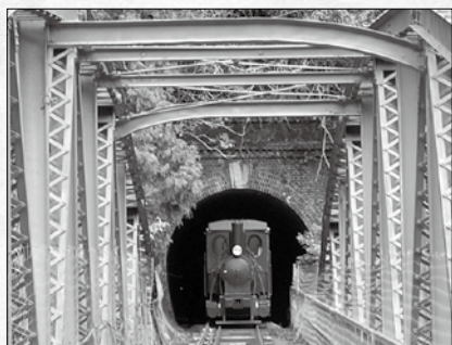
鉄道開通時に建設された鉱山鉄道で通過するトンネル
