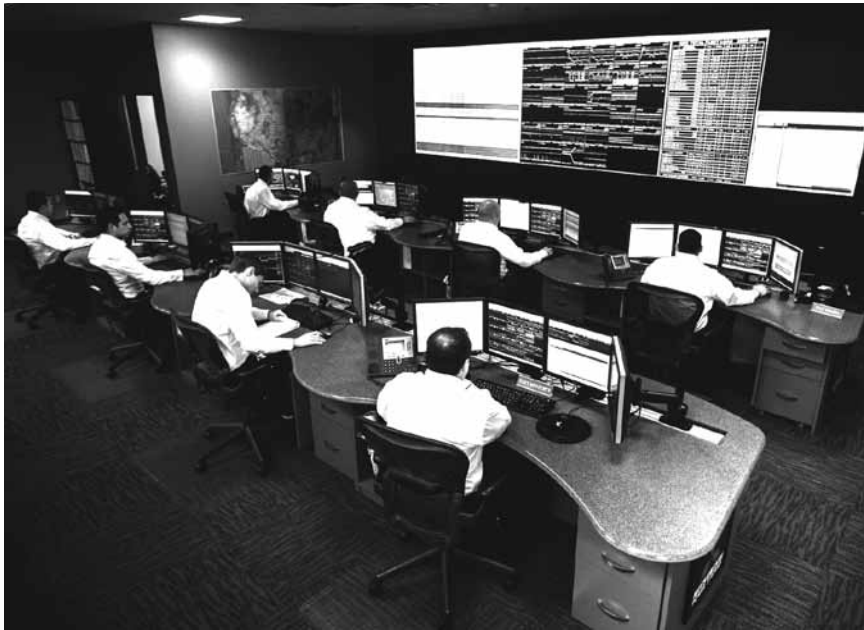
写真1 MHPSの遠隔監視センター
