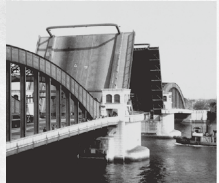
隅田川に架かる勝鬨橋が開いている姿 昭和25年撮影
