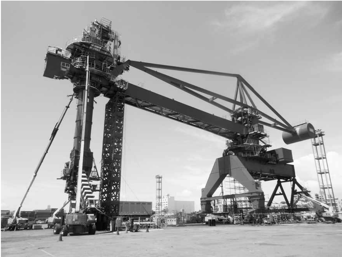
写真1 連続アンローダ全景
