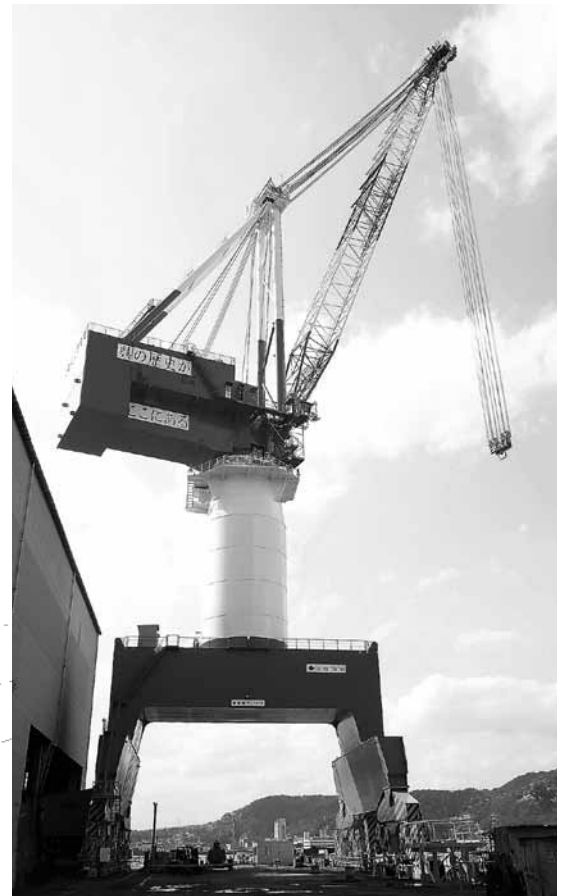
写真1 400tジブクレーン全景
