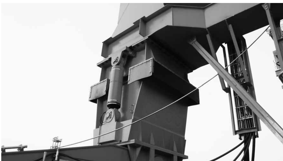
写真4 免震装置外観②（設置後）
