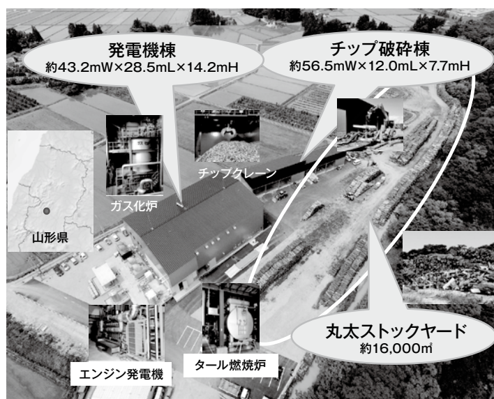
写真1 NKCながいグリーンパワー(株)全景
