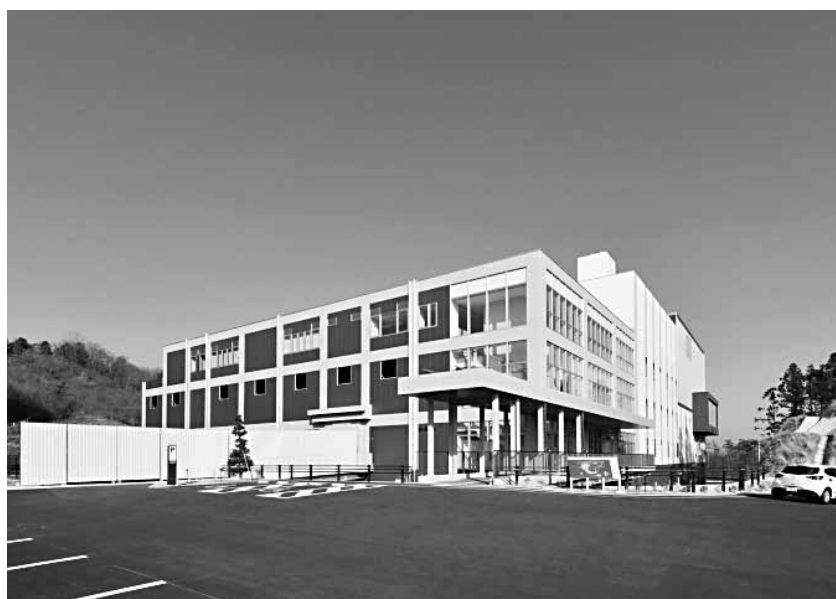
写真1 仙南クリーンセンター外観
