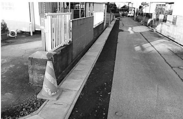
写真4 溶融スラグ入り落ち蓋式U形側溝試験施工実施状況
