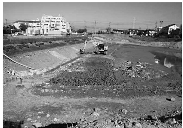
写真2 溶融還元石による基盤面整備状況
