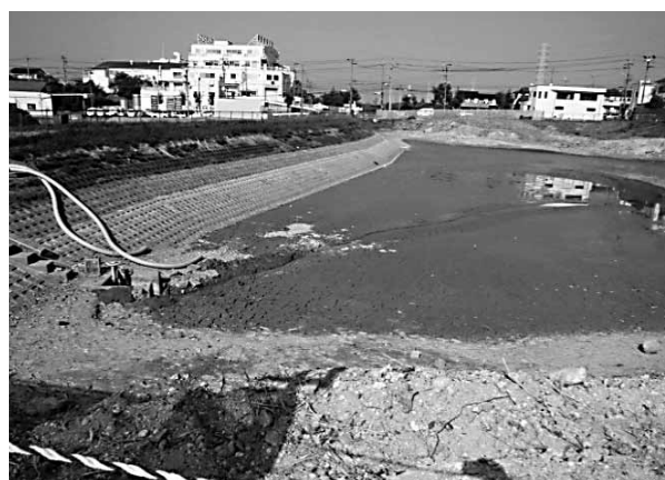
写真1 溜め池の状況(かいぼり後)
