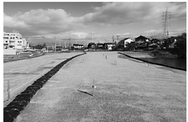
写真3 盛土後の状況
