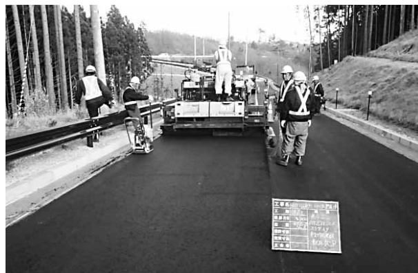
写真2 溶融スラグ入りアスファルト施工状況
