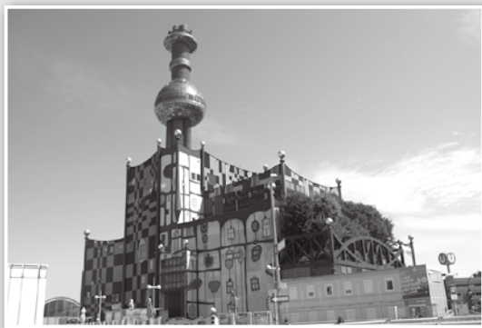
シュピッテラウ焼却場 (Fernheizwerk Spittelau)
