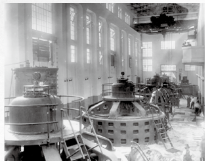
建設当時の大井発電所発電機室
