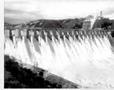
建設当時の大井ダム放流風景
