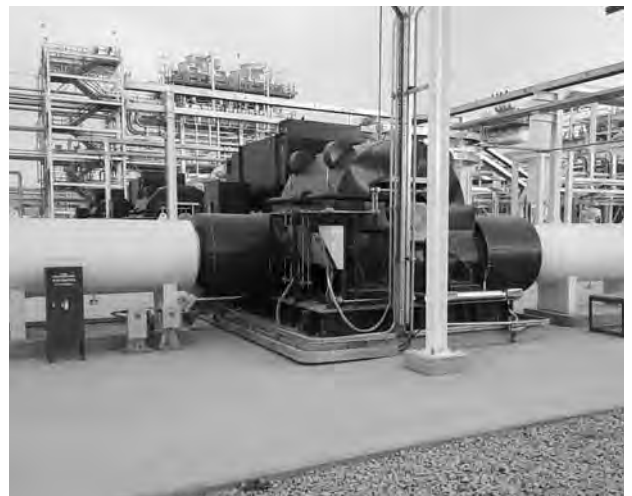
写真4 現地据付状況
