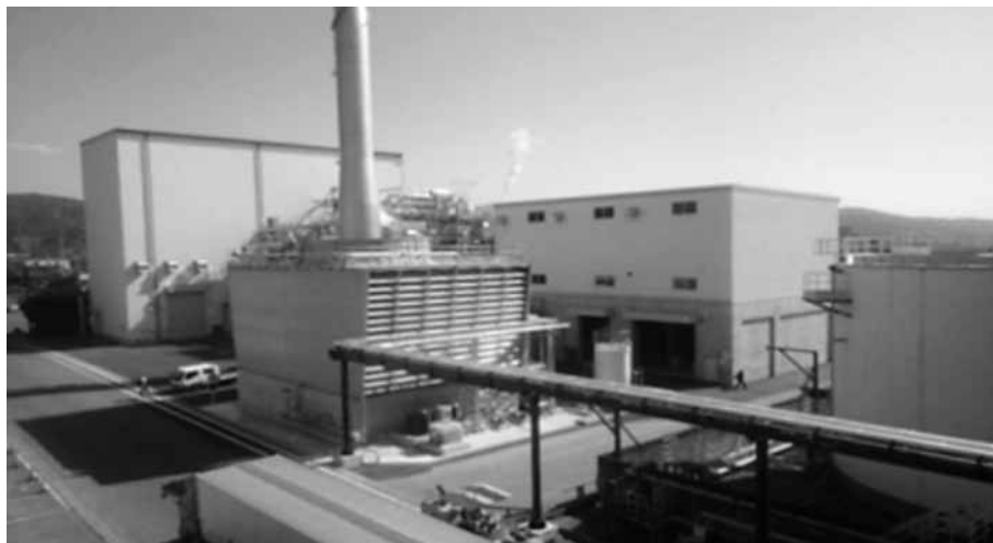
写真1 バイオマス発電設備の例
