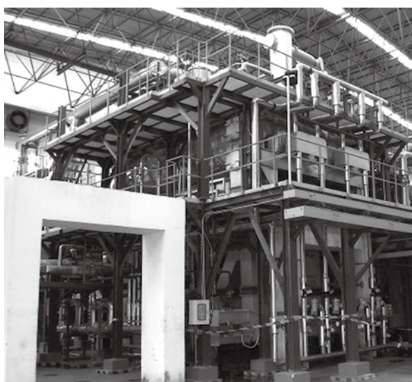
写真1 汚泥乾燥機 (MSD-200)
