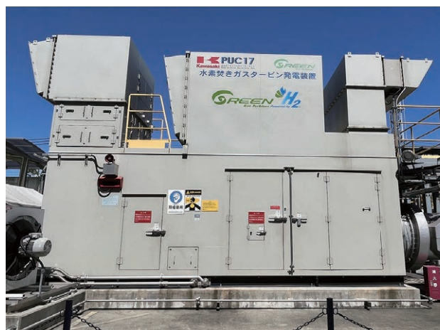
図2 水素焚きガスタービン発電装置
