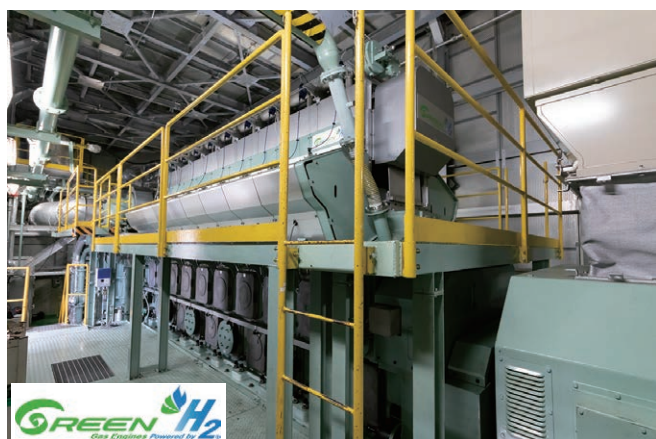
図4 水素混焼に対応したガスエンジンと発電設備
