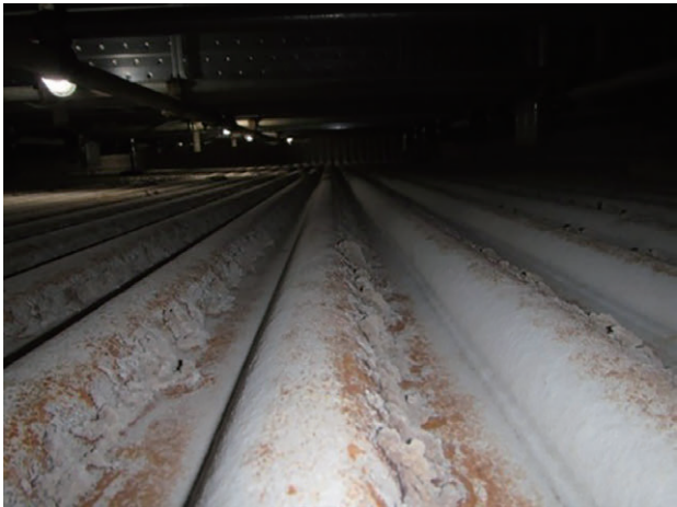
装置導入後 放射伝熱面 (200日間運転後)
