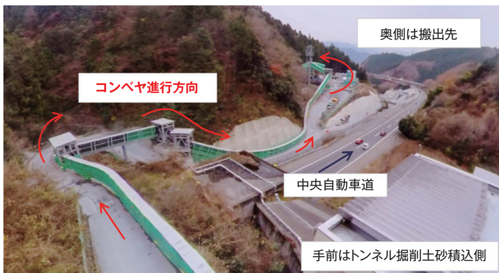
写真1 新小仏トンネル工事用SICON ®
