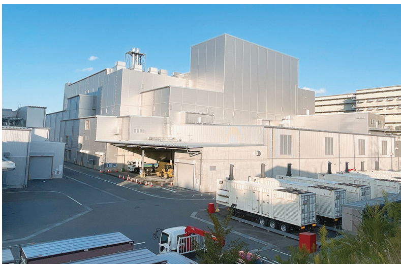
双葉町減容化施設の外観。中央のプラントが仮設灰処理施設。
