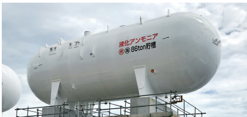
写真1 当社事業所内に設置している当社製の燃料用液化アンモニア貯槽
