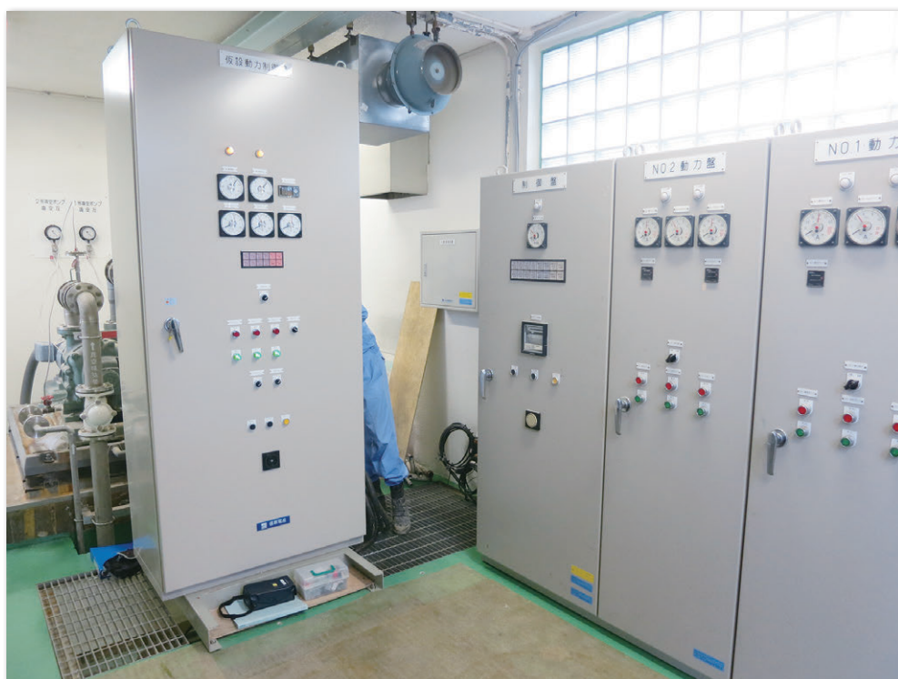
写真2 仮設盤設置例
