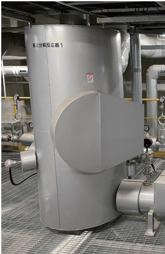
写真1 尿素分解反応器 外観(約2m×2m)
