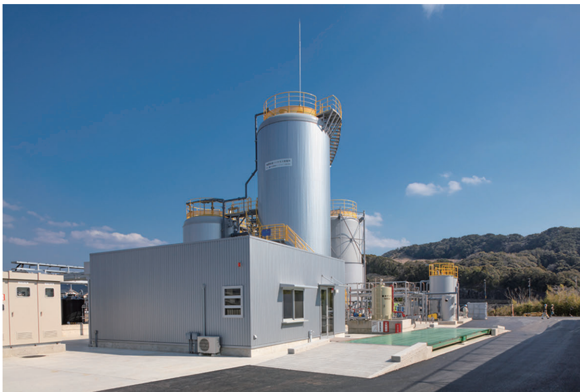
和歌山県西牟婁郡上富田町に新設された梅調味液バイオガス発電所
