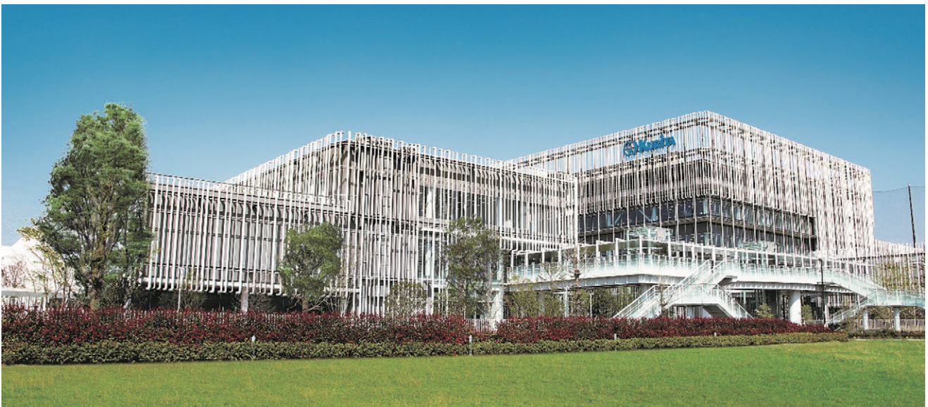
▲ KIH 外観 水処理装置に用いる「配管」を抽象化した外装が、時間や天候の周辺環境の変化に応じて様々な様相で現れ、美しい景観をもたらすよう施しています。
