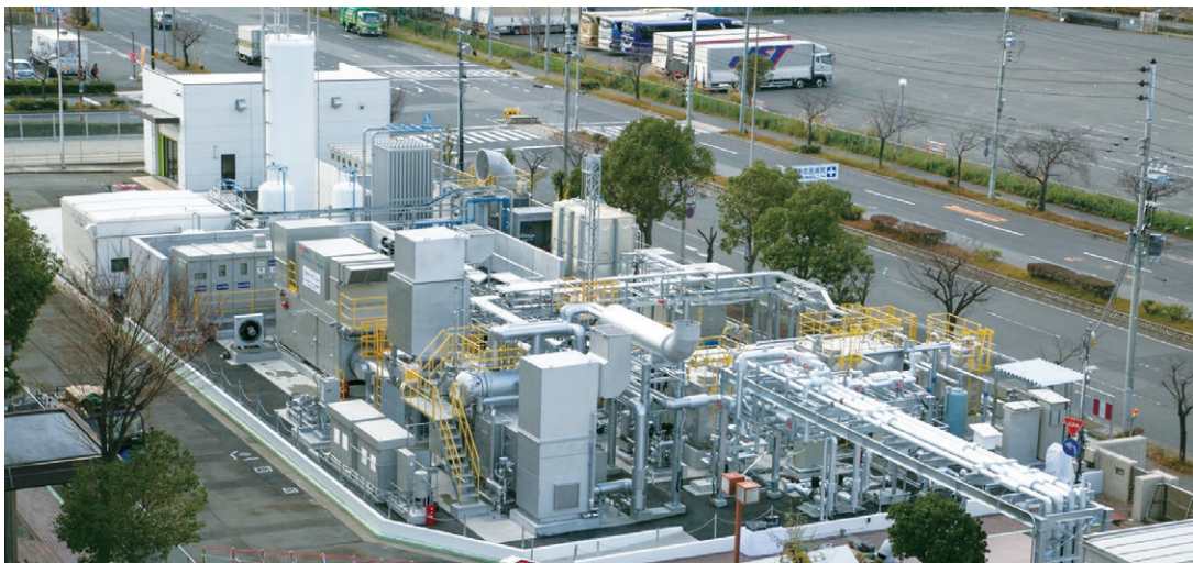
写真1 水素コージェネレーションシステム実証プラント
