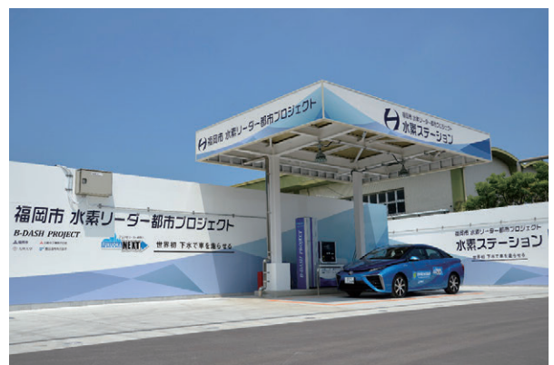
下水バイオガス由来の水素による水素ステーション(福岡市)
