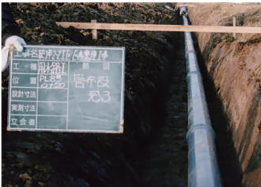
⑤ パイプライン管設置完了
