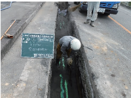
写真3 管周りスラグの胴締め
