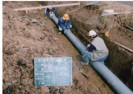
④ パイプライン管設置作業
