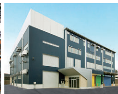
直営廃棄物処理施設(ごみ発電)
