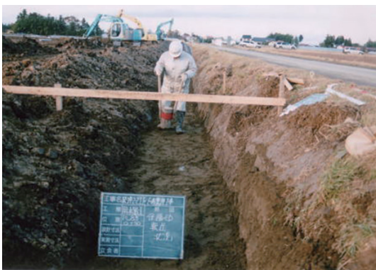
⑦ 埋戻材転圧
