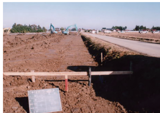
⑧ パイプライン施工完了
