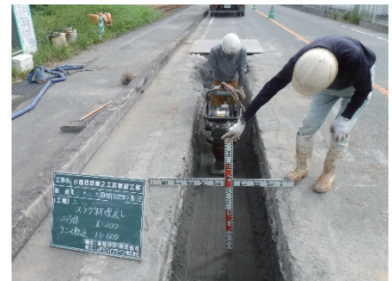
写真5 二層目スラグのランマ転圧
