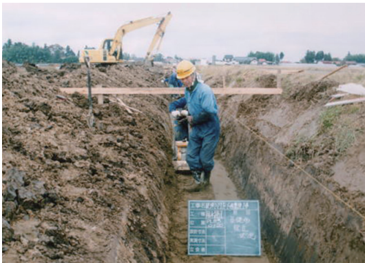
③ 基礎材転圧
