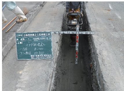
写真4 一層目スラグのランマ転圧
