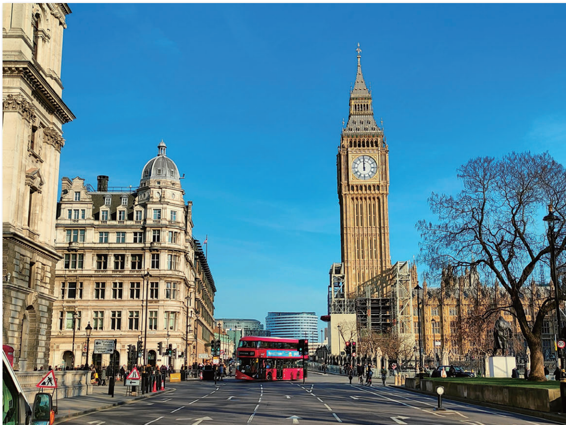
改修が終了間近のロンドンのシンボル、ビッグベンの様子
