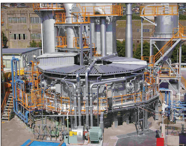
写真1 朝日工業殿向けRHF設備外観
