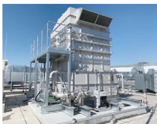
デオライザー食品工場排ガス処理
