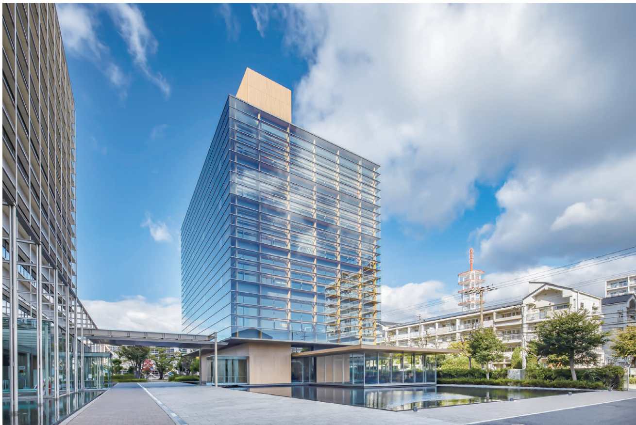
写真1 タクマビル新館(研修センター)全景
