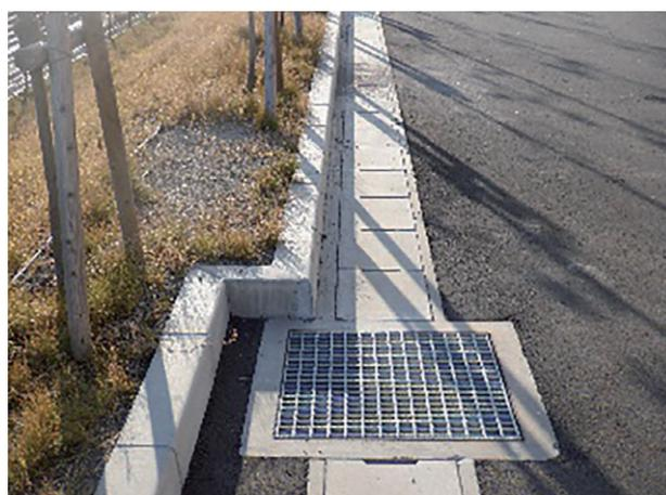
写真4 道路側溝(プレキャストコンクリート製品)
