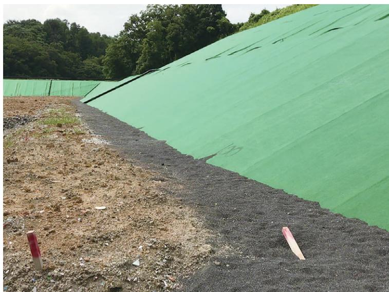
写真4 溶融スラグを用いた法面保護土
