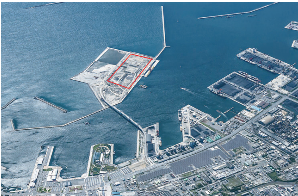
写真1 小名浜東港 石炭ターミナル地区 (出典:株式会社IHI HPより)
