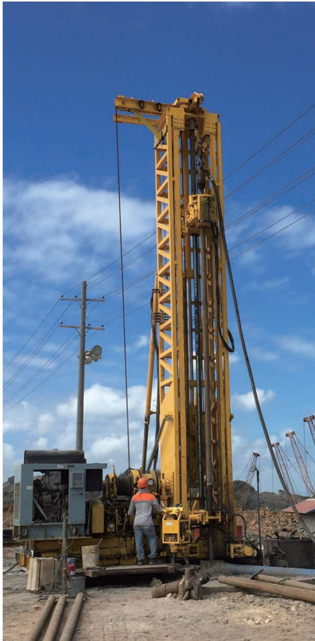
写真1 CHM(センターホールマシン)掘削の様子
