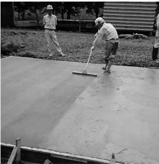
写真5 施工状況③(仕上げ)
