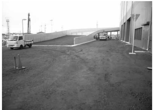
写真2 路盤の施工状況
