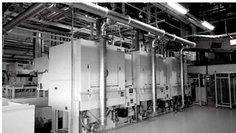
写真5 機械後部は増設スペース
