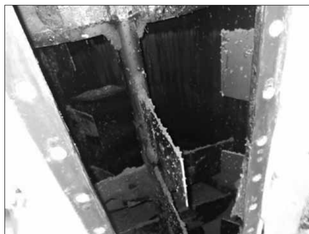
写真2 凝集混和槽攪拌機 破碎機設置後
