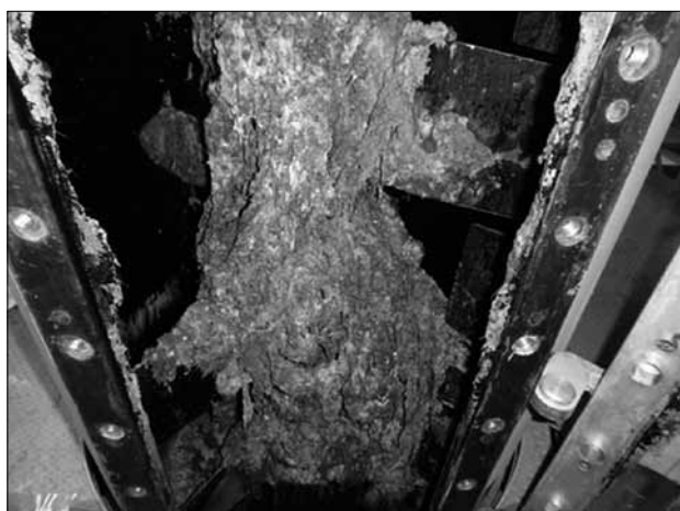
写真1 凝集混和槽攪拌機 破碎機設置前
