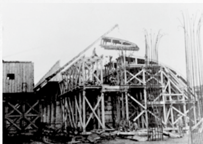
工事中のドーム
