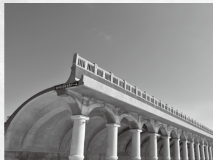
稚内港北防波堤ドーム
