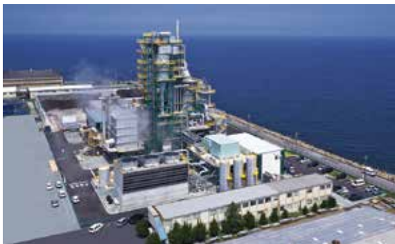
写真1 バイオマス発電プラント
