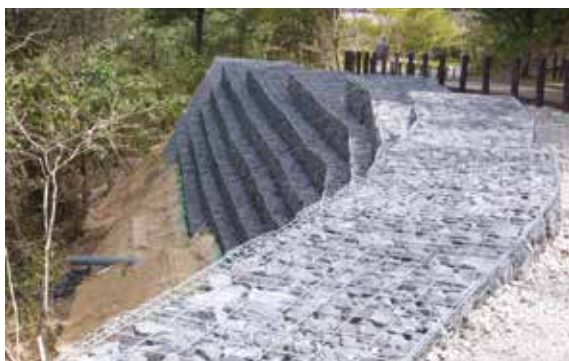
写真7 徐冷スラグを金属かごの中詰め材に用いた施工例
