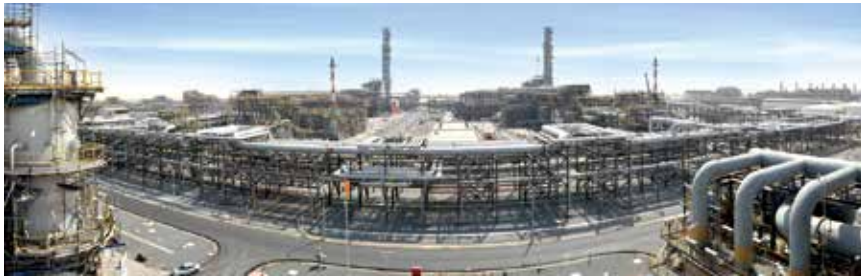
写真3 ガス処理プラント
