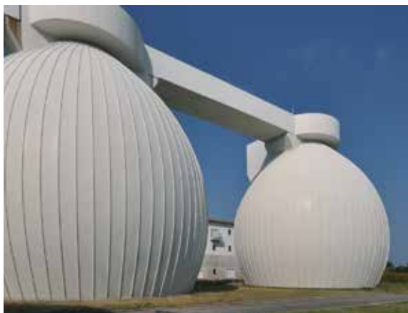
写真4 汚泥消化槽 (燃料化施設)
