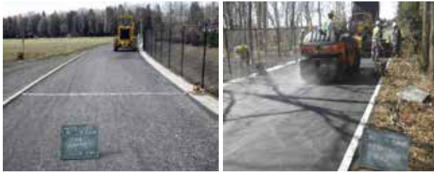
写真3 道路用施工状況(左:路盤材、右:加熱アスファルト合材)
