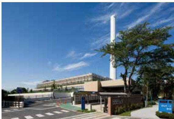
写真1 都市ごみ処理施設（東京二十三区清掃一部事務組合・杉並清掃工場）
