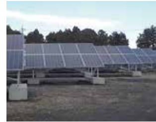
写真4 メガソーラ太陽光パネル用路盤材への施工例
