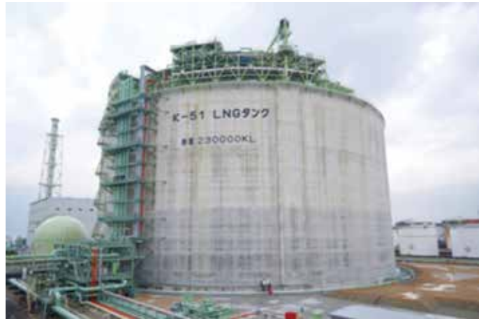
写真2 大容量23万klのLNGタンク「泉北製造所第一工場5号LNGタンク」 (引用元：大阪ガス株式会社ウェブサイト)
