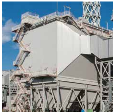
写真7 最新石炭火力発電所の集塵装置
