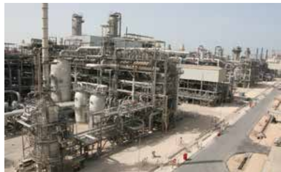
写真2 LNGプラント (提供:カタールガス社)
