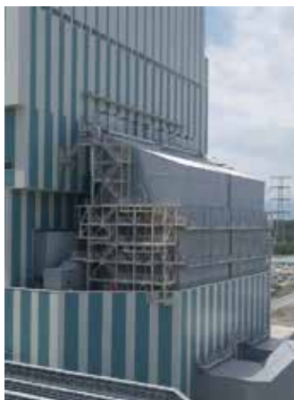
写真6 最新石炭火力発電所の脱硝装置
