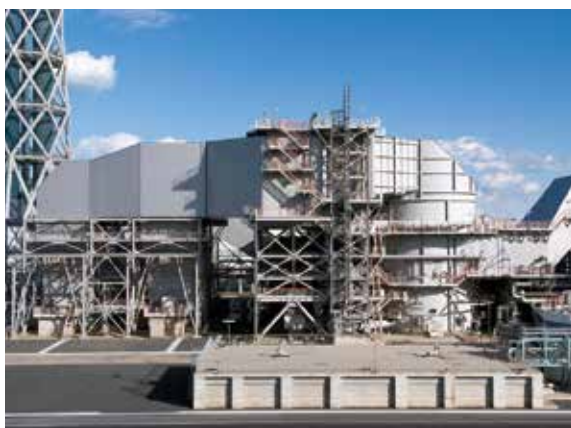
写真8 最新石炭火力発電所の脱硫装置
