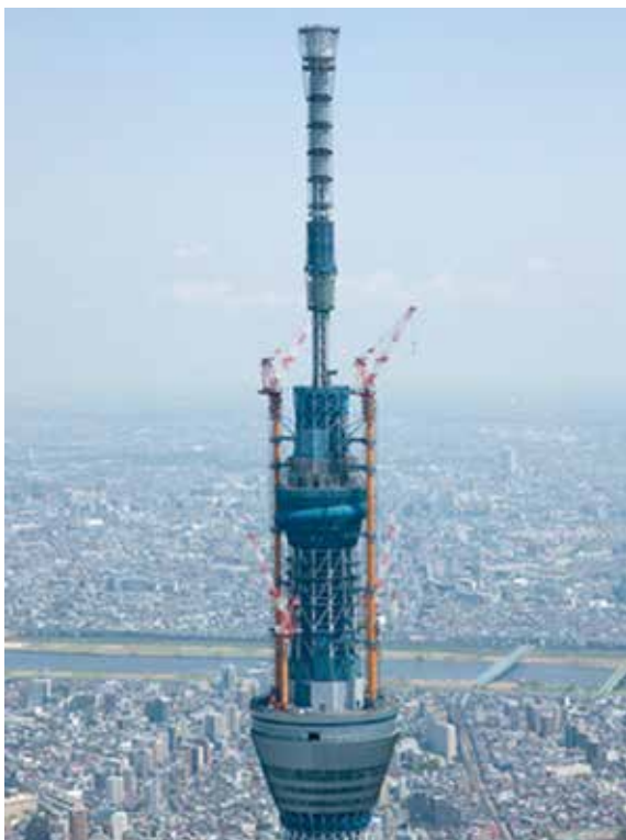
写真5 ジブクライミングクレーン(建設)
