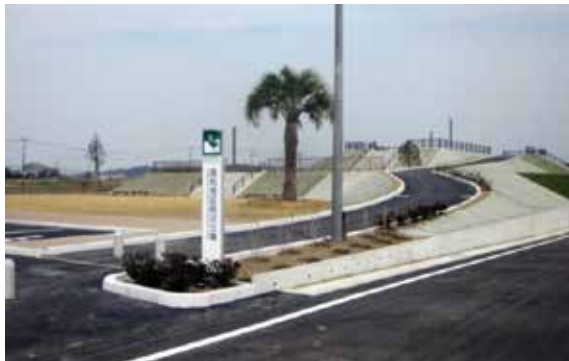
写真5 盛土工事の中詰材にエコスラグ入り路盤材を利用した防災公園
