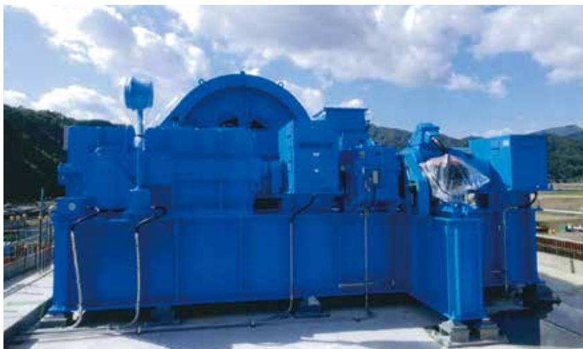
写真1 津波等水害対策用河川ゲート開閉装置（提供：株式会社大阪減速機製作所）
