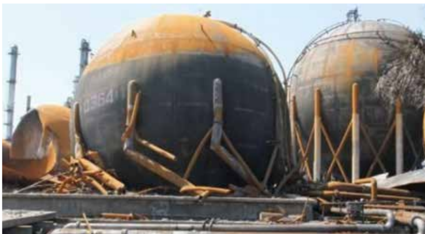
写真1 倒壊した球形タンク（引用元：高圧ガス保安協会ウェブサイト「高圧ガス事故概要報告」）
