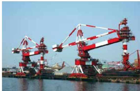
写真4 連続式アンローダ(発電所)
