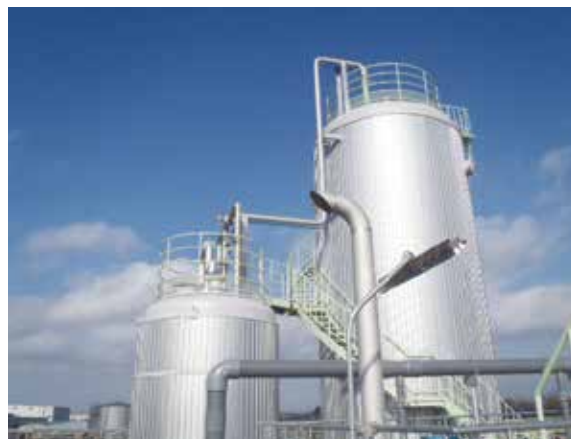
写真5 嫌気処理装置 (燃料化施設)
