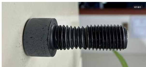
写真1 強度不足により伸びた取付ボルト
