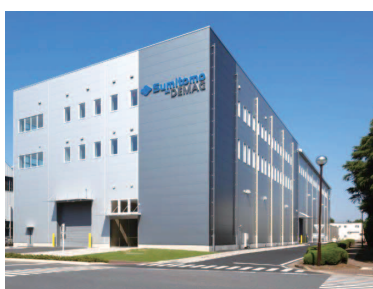
Pic.5 千葉製造所の新工場の外観
