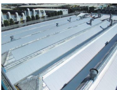
Pic.6 スレート屋根の二重化(施工中)
