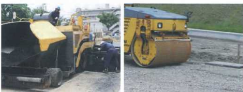
アスファルト舗装
