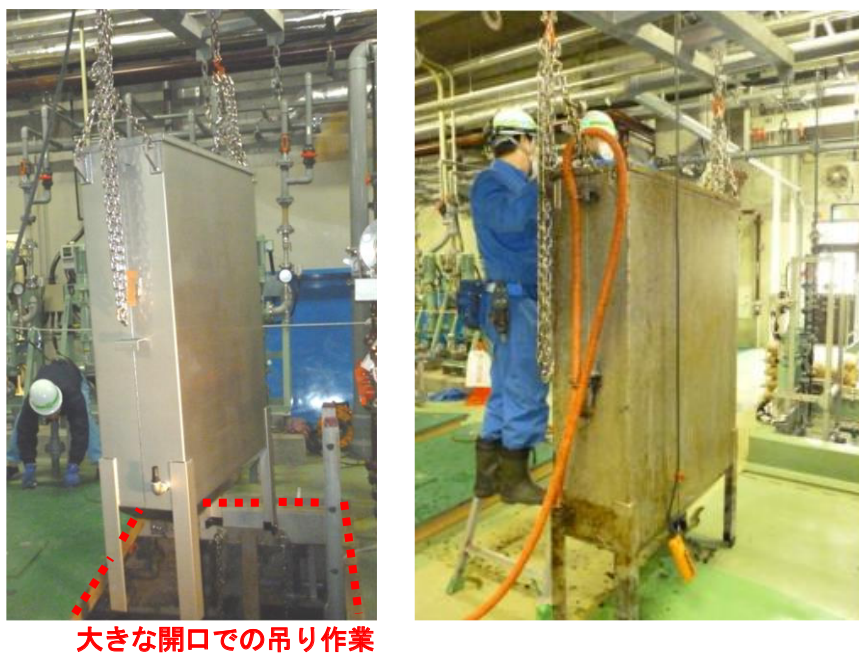
図表 9 槽内型リアクタの引き揚げ作業（左）と点検作業（右）
