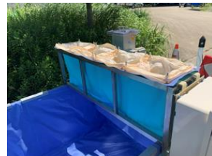
5) 汚泥脱水槽内部
